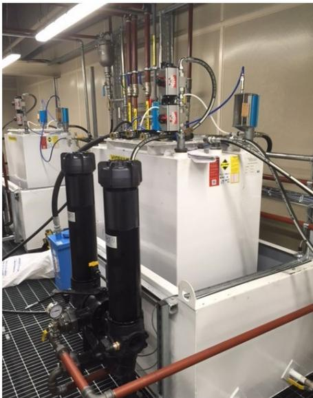
Гидравлические резервуары с линейными дуплексными фильтрами LMD 431
