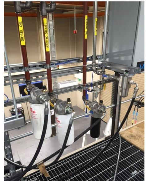
Картриджный фильтр для дизельного топлива и моторного масла
